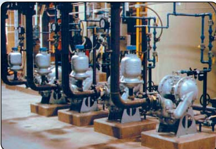
Bombas HDB con descarga inferior con puertos y tranquilizadores en una instalación de tratamiento de desechos industriales.
