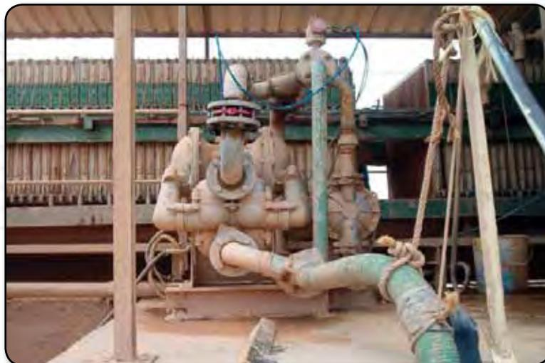
La bomba con la parte inferior con puertos de 3" se encuentra instalada como una bomba de suministro con presión de filtros de placa y de cuadro con revestimiento previo.
